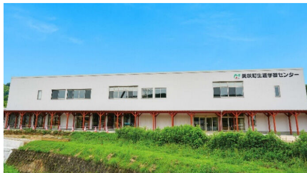
[美咲町生涯学習センターの外観]
